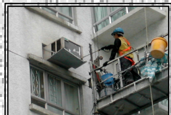
採用水壓機清洗方法
