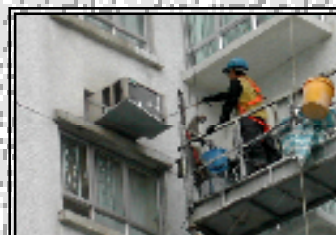
採用水壓機清洗方法
